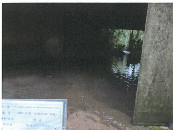
河川水採水箇所NO2 地点状況
