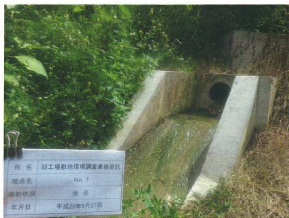
No. 1 地点状況
