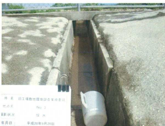
No. 3 地点状況
